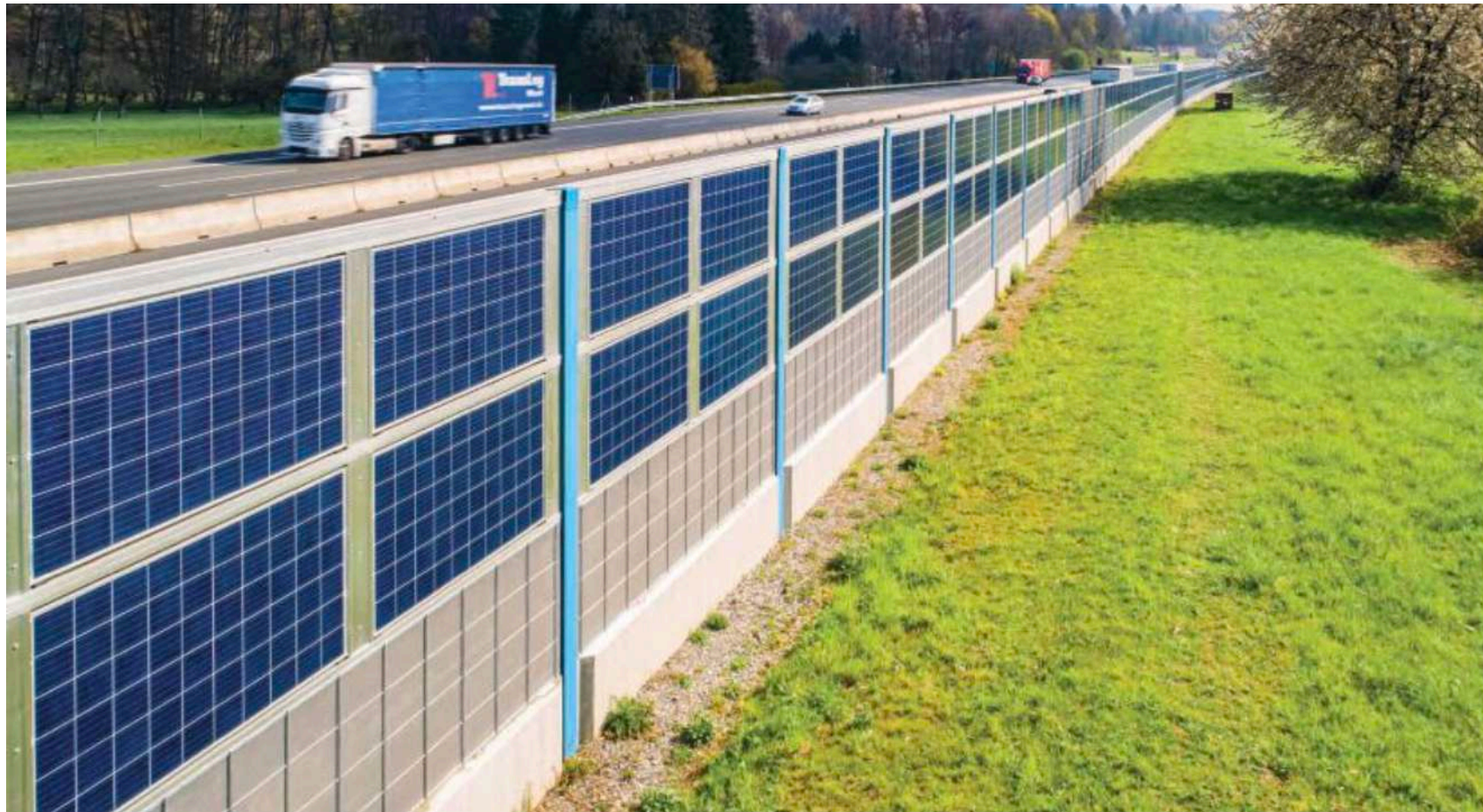
ドイツ・アシャフェンブルク近郊の連邦高速道路3号線の道路脇
